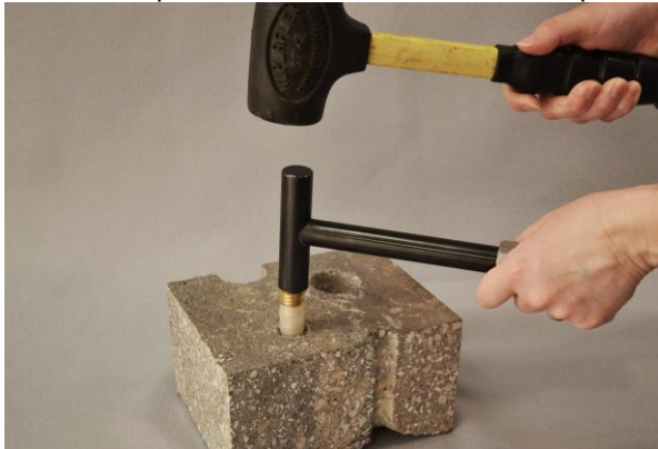
Figura 2. Instalando o FLX-VP
