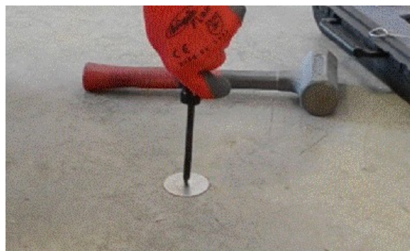
Figura 5. Apertando a Tampa de Proteção.
