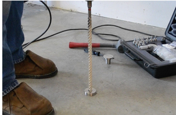
Figura 4. Uso da Guia de Perfuração.
