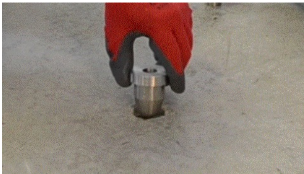
Figura 3. Instalação da Guia de Perfuração.
