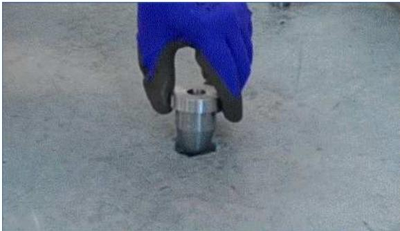
5) Lorsque le trou de diamètre de 1 1/2 po est foré à la bonne profondeur, remplacer le foret avec un mèche de diamètre de 5/8, insérer la mèche à travers le guide de forage (figure 4), et percer à travers la dalle. Le guide de forge aidera à centrer le trou pour le Vapor Pin™, tout en maintenant le trou perpendiculaire à la dalle.
