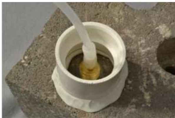
Figuur 6. Waterdam gebruikt om lekkage te detecteren
