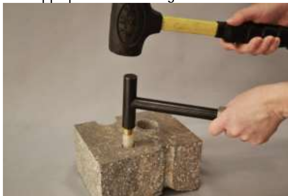
Figuur 2. Installatie van de damp-pin
