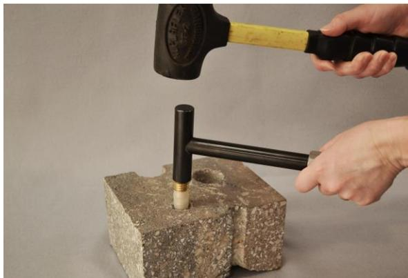
Figure 2. Installation du Vapor Pin
