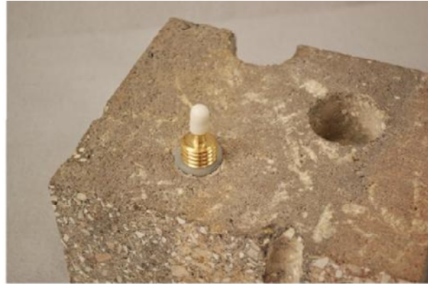
Figura 4. Vapor Pin® instalado.
