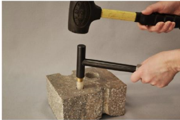
Figura 2. Instalação do Vapor Pin®.
