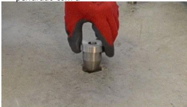
Figura 3. Instalação da Guia de Perfuração.
